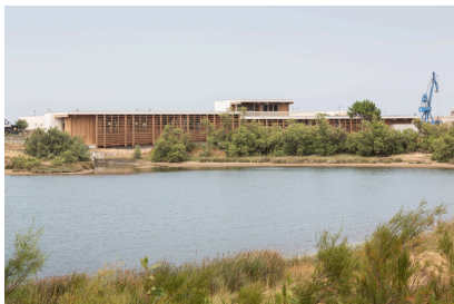
© Projet XB Architectes / Photo Studi-A
